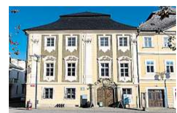
Opraví ho? Sankturinovský dům potřebuje opravy hlavně v interiéru. Foto: M. Šula, MAFRA
